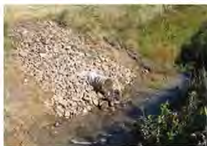
Photo 2 : Protection avec pierres de champ Source : Régis Potvin (MAPAQ)
