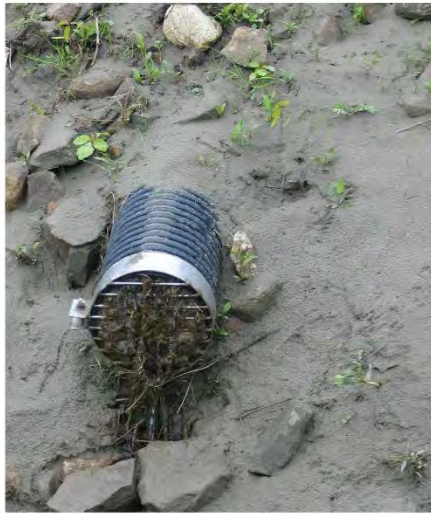
Photo 3 : Grille partiellement obstruée Source : Mikael Guiliou (MAPAQ)
