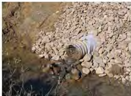
Photo 1 : Sortie de drain avec grille amovible Source : Régis Potvin (MARAQ)
