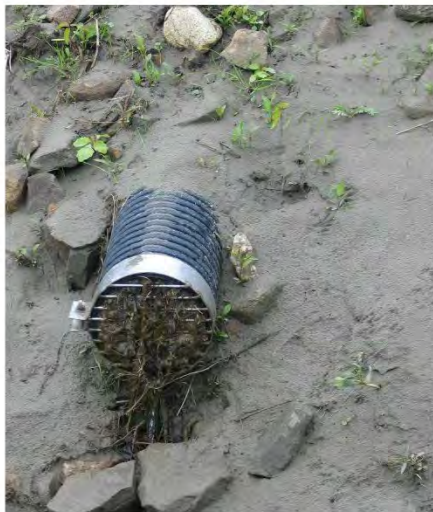
Photo 3 : Grille partiellement obstruée Source : Mikael Guiliou (MAPAQ)
